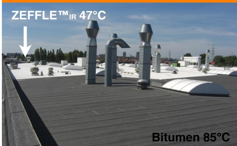
Die verringerte Temperatur des Daches bildet die Grundlage für effektive passive Kühlung!
