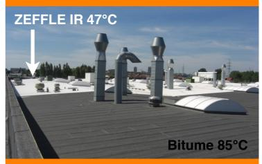
La riduzione della tempertura del tetto costituisce il punto di partenza del raffrescamento passivo
